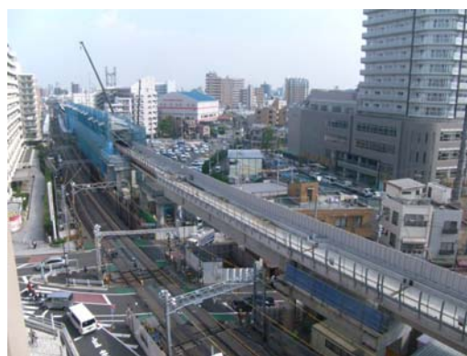
墨田区内連続立体化工事 押上駅～京成曳舟駅間 計画線高架橋
